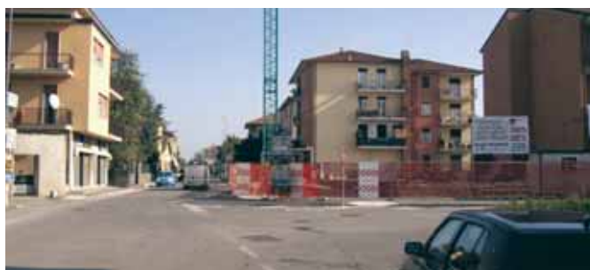
Durante i lavori.
