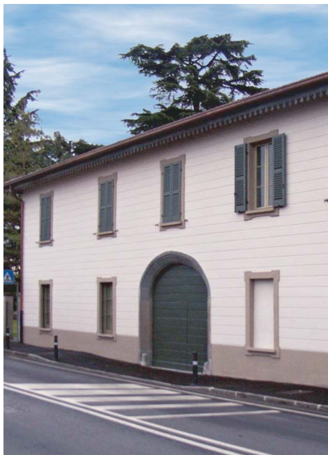
Palazzina nord edificio municipale recentemente restaurato
